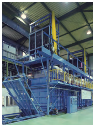
三重工場 メッキ設備
